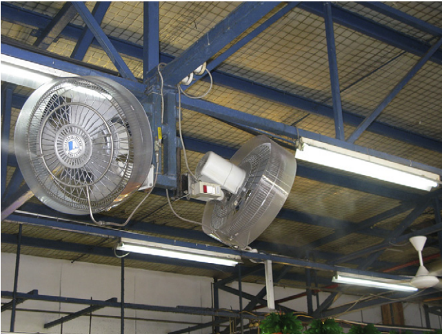
Fig. 2. Misting fan system.
